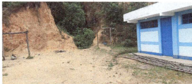
Foto 2: Sustrución de piso de torta de concreto
