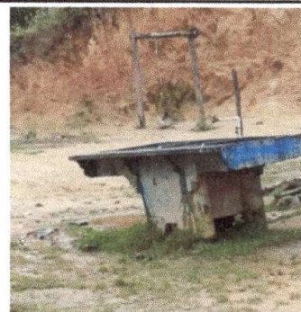
Foto 6: Sustrución de pila de cemento de dos lavaderos (tanque)
