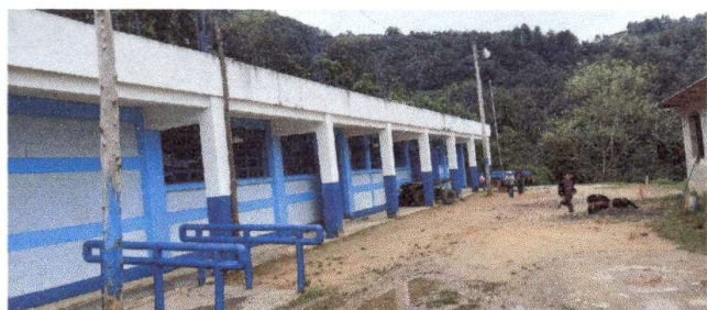
Foto 3: Pintura en muros exteriores e interiores
