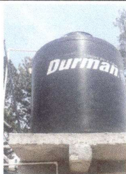
Foto 5: Sustrución de deposito de agua 2,500.lts
